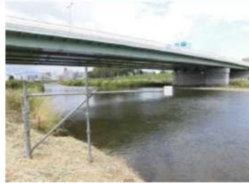
水位計表示機
