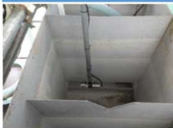
pHセンサー部設置状況
